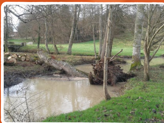
Arbre qui aurait nécessité d'un abattage préventif - Crédit photo : M. Douane
