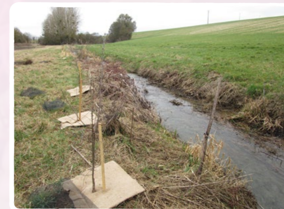
Paillis et filet de protection en cours de mise en place à Fontenoy - Crédit photo : M. Douane
