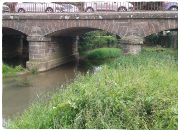
Bancs végétalisés au droit d'un pont sur l'Ouane - Crédit photo : M. Douane
