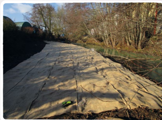
Pose de géotextile pour limiter la repousse de la renouée à Saint-Fargeau - Crédit photo : M. Douane
