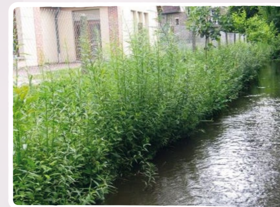
Boutures de saules un an après travaux (27) - Crédit photo : Syndicat intercommunal de la vallée de l'Avre
