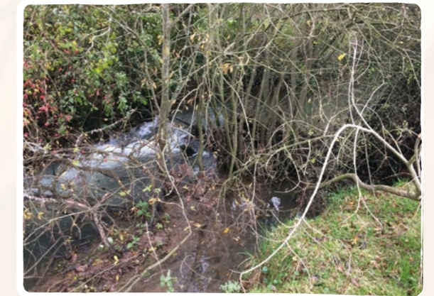
Arbustes dans le lit du cours d'eau à couper - Crédit photo : UniLaSalle
