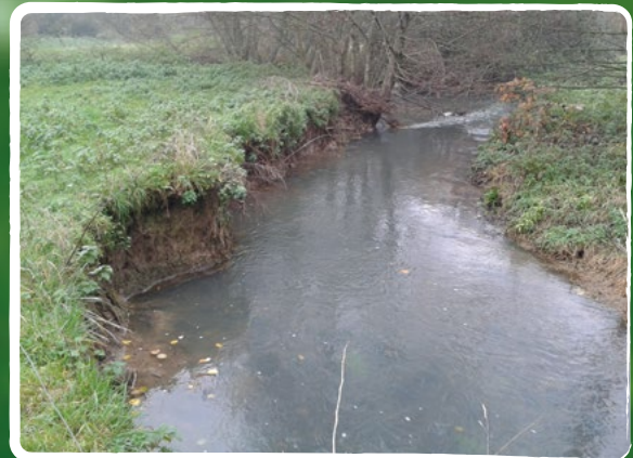
Érosion de berge sur le Loing à Saint-Privé- Crédit photo : M. Douane
