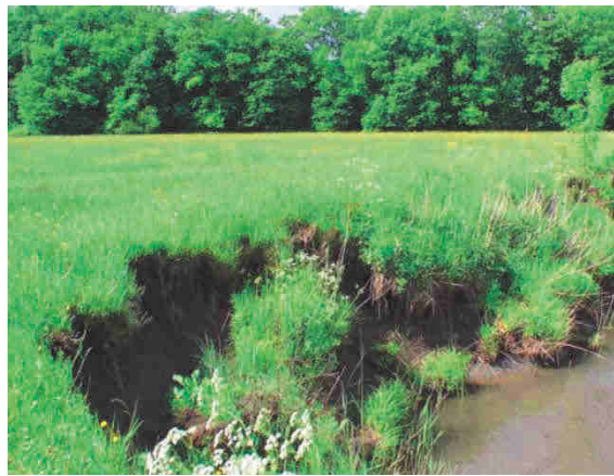
Exemple de glissement de berge
