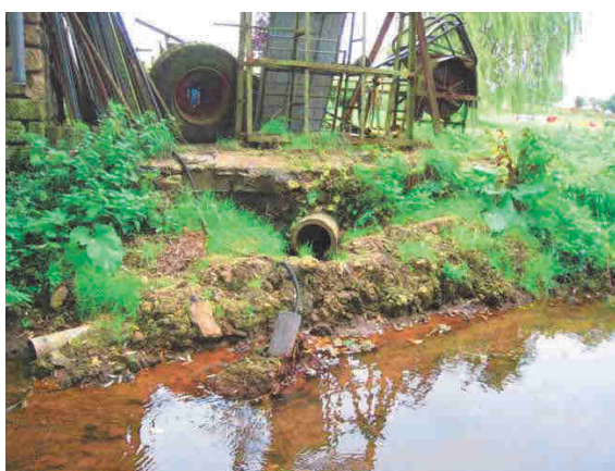
Exemple de déchets en berges, avec aménagement rustique d'une crépine
