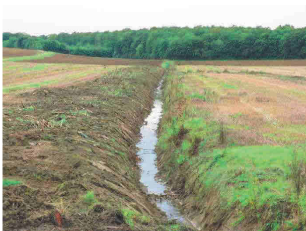
Exemple de curage avec régalinge en berge
